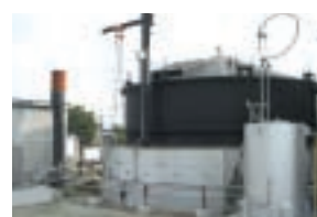
食品廃棄物をバイオガスにする施設
