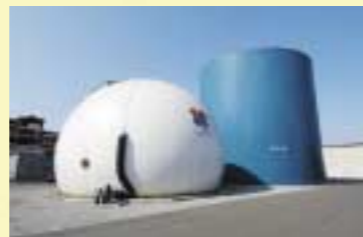
バイオガス化施設(ガスホルダー)
